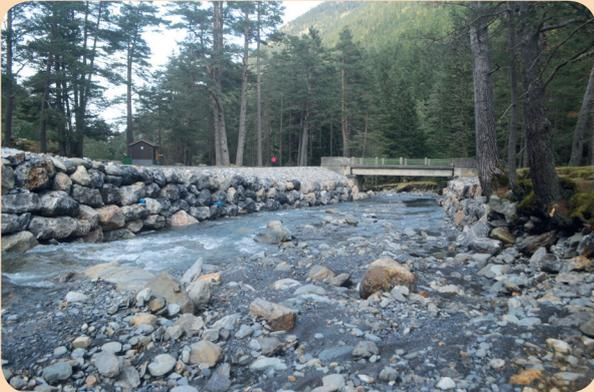
Suite aux dégâts causés par les crues de 2013 et 2015, de nouveaux enrochements ont été réalisés sur berges de la Neste, en aval du pont de Frédancon.
