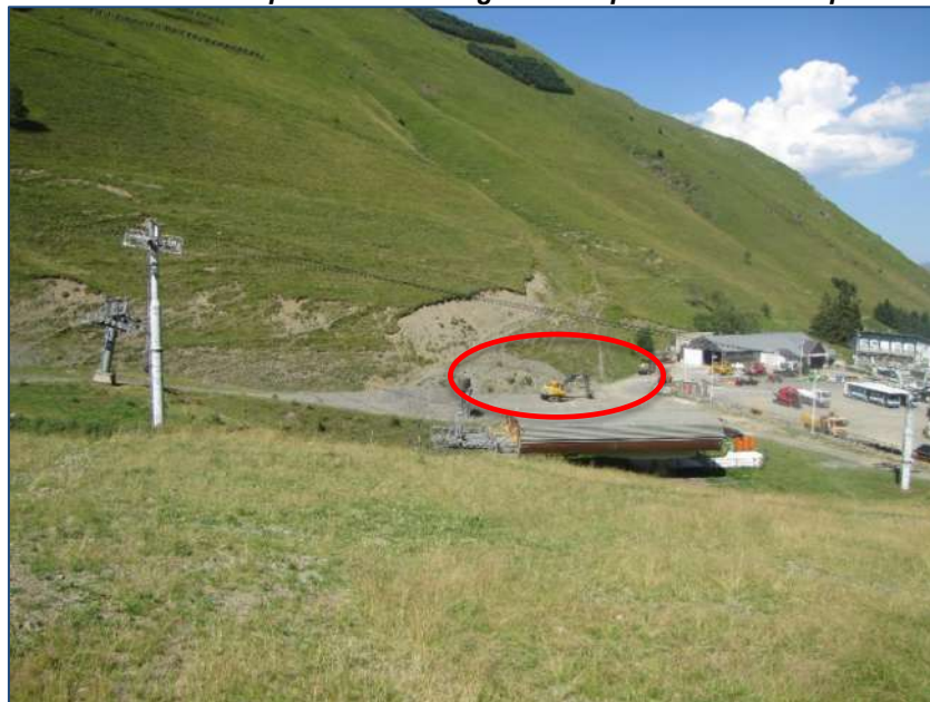
Photo n° 4 : Vue de l'emplacement de la gare de départ du futur Téléporté d'Espiaube
