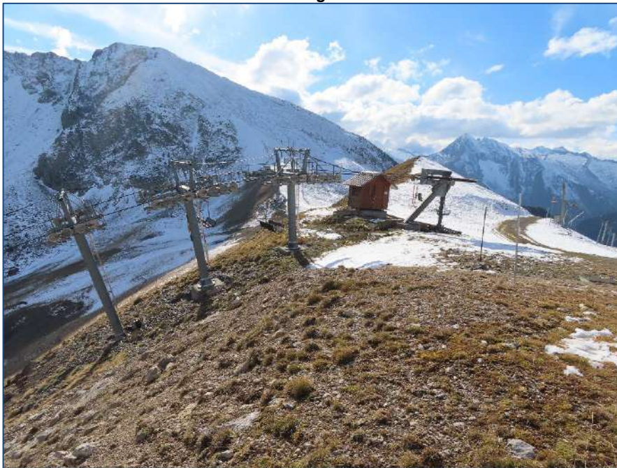
Photo n° 10 : Vue de la gare amont actuelle du TSF Tortes
