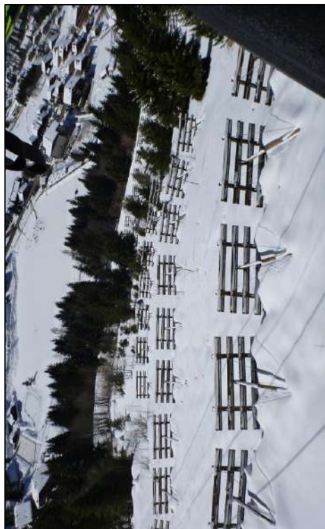
Figure 18: Exemple d’ouvrages mono-ancrages bois (C36)
