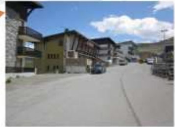
Résidences linéaires sur voirie R+2
