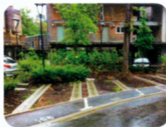
Exemples de dispositifs et de matériaux pour réduire les surfaces imperméables : mélange terre pierre, pavé béton sur lit de sable, etc.
