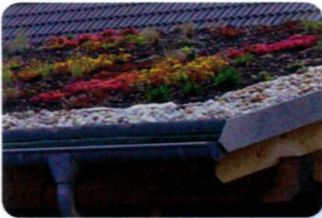
Toit végétalisé (Postdam)
